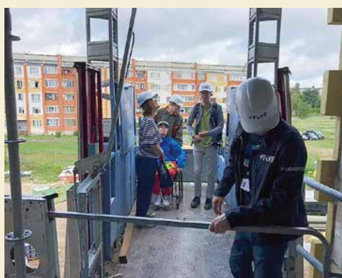
Būvniecības procesā, lai kontrolētu pieejamību cilvēkam ratiņkrēslā.
